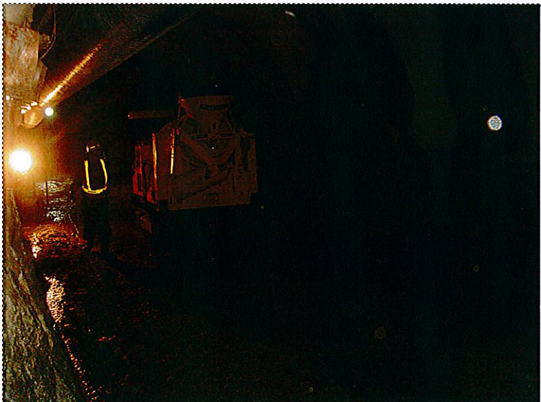
8 生コン投入後、自走にて移動
