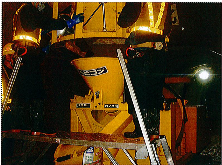
7 ミキサーホッパーに 生コン投入
