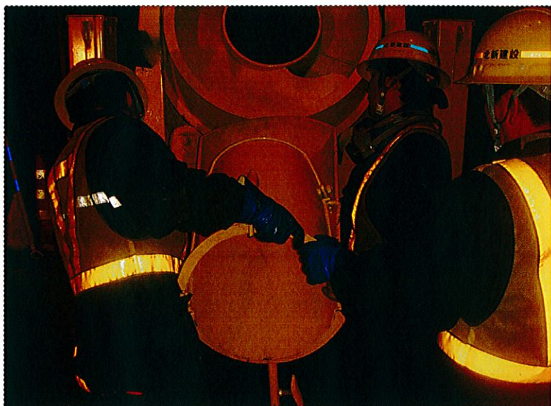
19 シューター部を設置
