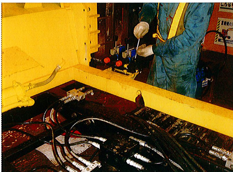
15 リフトアップ操作スイッチ取付
