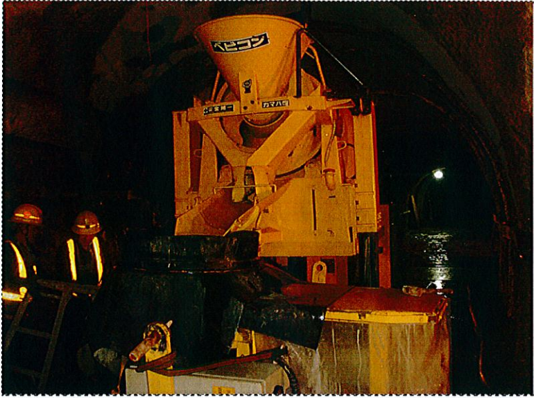
10 リフトアップにて設置
