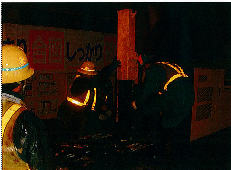
12 リフトアップシリンダー 設置
