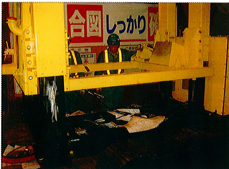
16 リフトアップの確認作業
